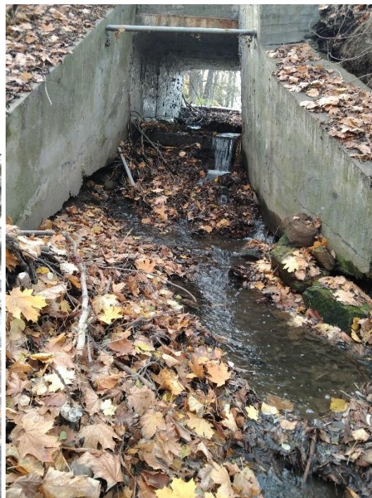
Body 29 a 30 – havarijní stav bezpečnostního přelivu Ctěnického rybníka
