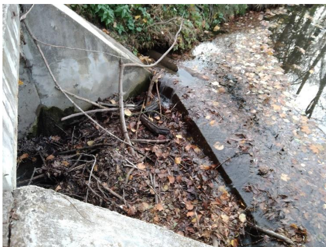
Body 29 a 30 – havarijní stav bezpečnostního přelivu Ctěnického rybníka
