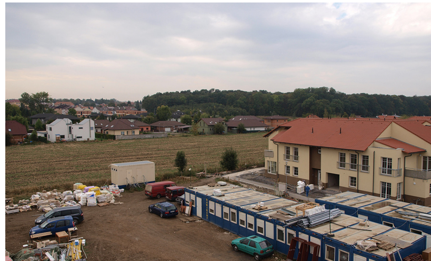
Nahled na střední část lokality z rozestavěného domu v souboru Zlatý kopec
