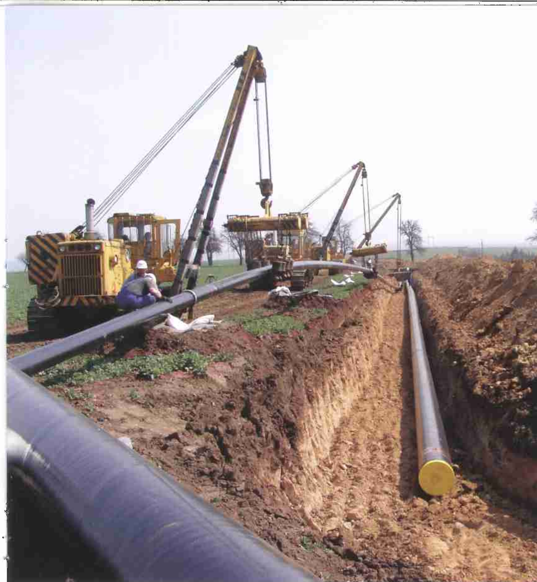
Ropovod Družba – výstavba obchvatu Kolína
