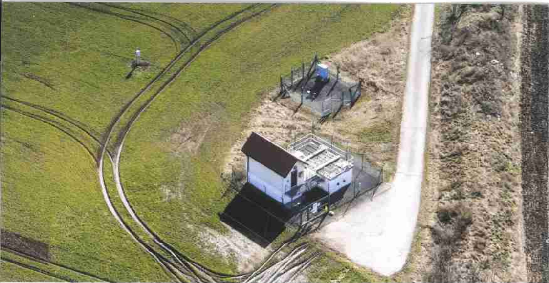
Armaturní šachta – uzávěra ropovodu vybudovaná na trase vždy po několika kilometrech
